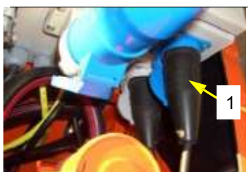
Рис. 45: Включение воздушного компрессора
